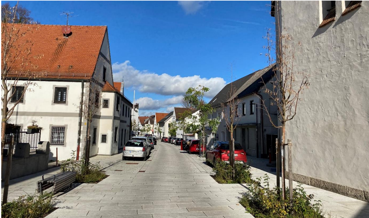
Abb. 31 Sanierter Straßenraum Herrnstrasse
