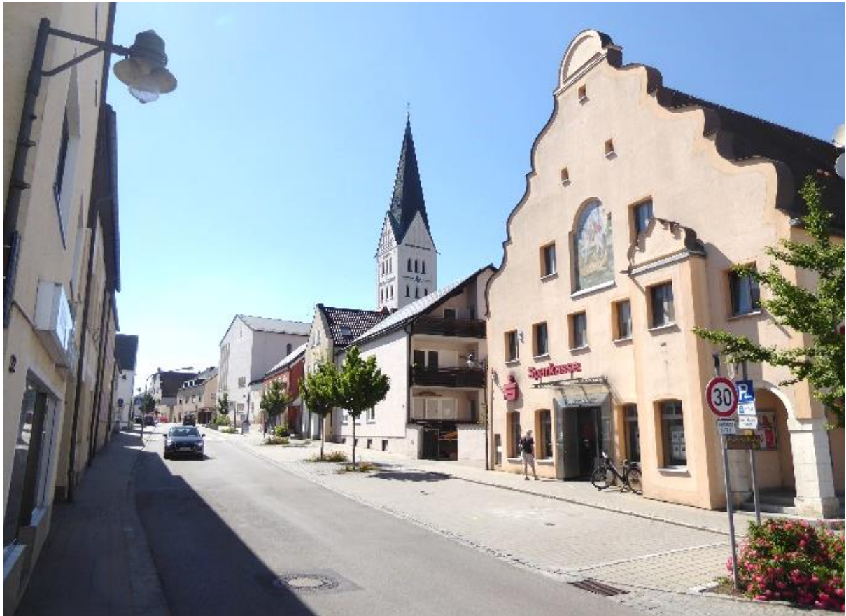
Abb. 18 Barocker Schweifgiebel im Straßengefüge der Marktstraße
