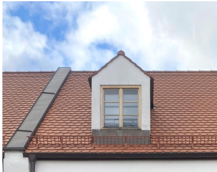
Abb.22 Beispiel für Satteldachgaube
