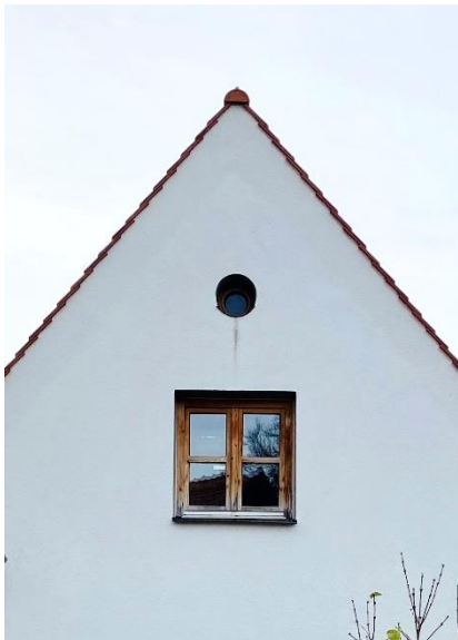
Abb. 21 Beispiel für Ortgangausführung
