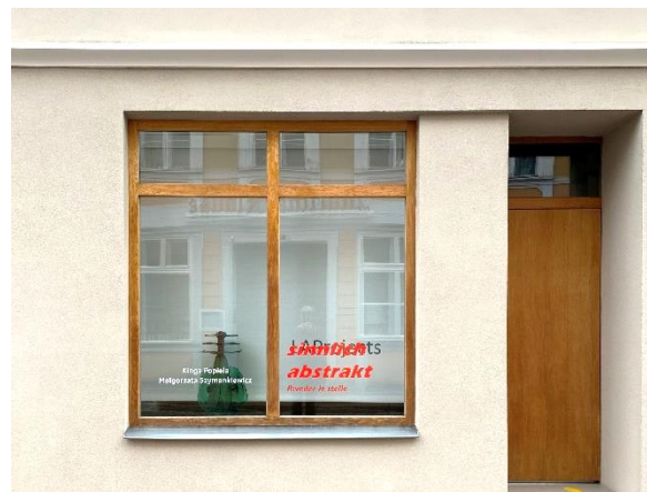
Abb. 30 Beispiel für ein wiederhergestelltes Schaufenster an einem historischen Gebäude
